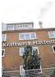
Das Dampfkraftwerk Hastedt wurde 1905 gebaut. Es ist das älteste Kraftwerk in Bremen.
