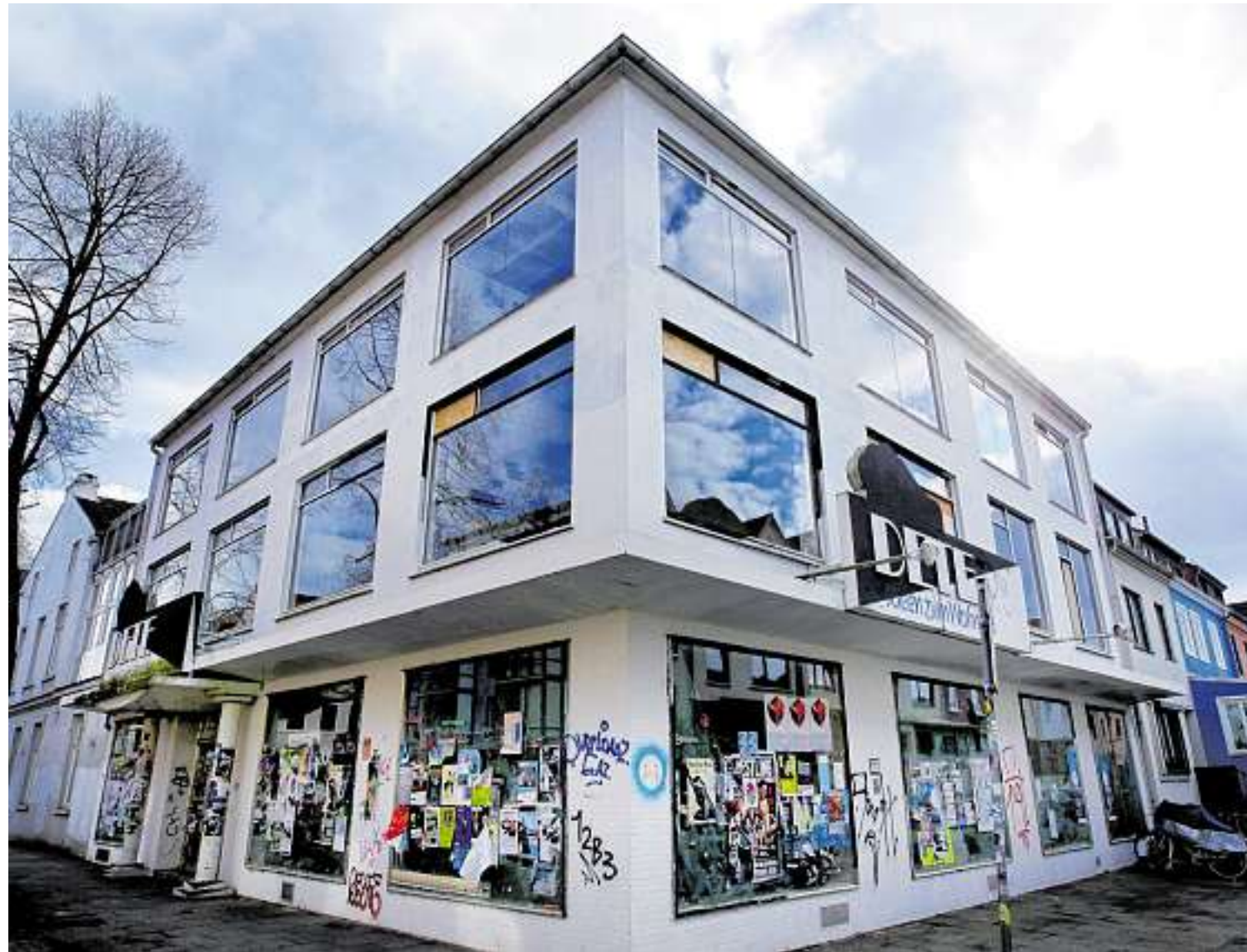
In diesem Gebäude an der Lahnstraße befand sich zuletzt das Kulturzentrum „Dete“. Es steht seit über zwei Jahren leer.
