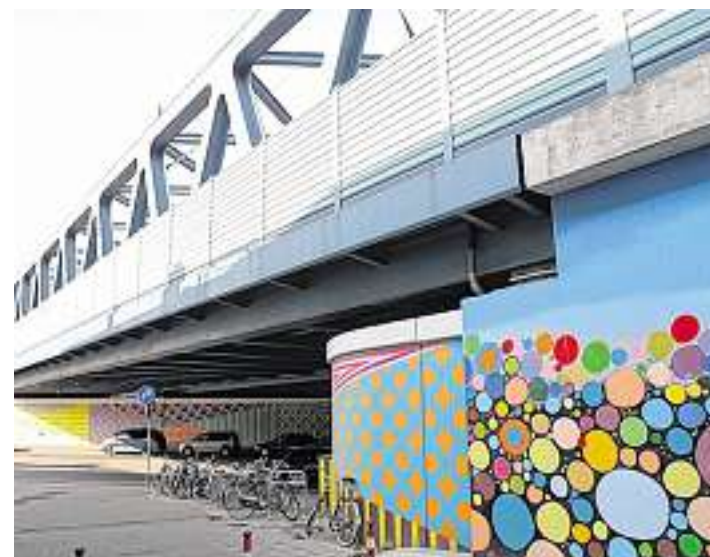
Der Concordia-Tunnel. Oft ist die Lärmbelastung sehr hoch. Kaum ein Ort zum Verweilen – außer beim urbanen Spaziergang.
