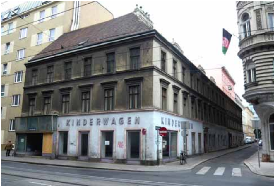
Bestandgebäude von VinziRast-Mittendrin vor dem Umbau
