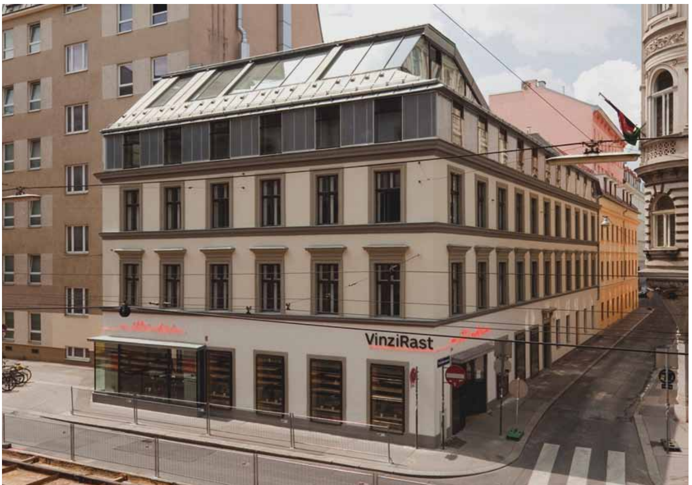
Bestandgebäude von VinziRast-mittendrin nach dem Umbau, © Sebastian Schubert
