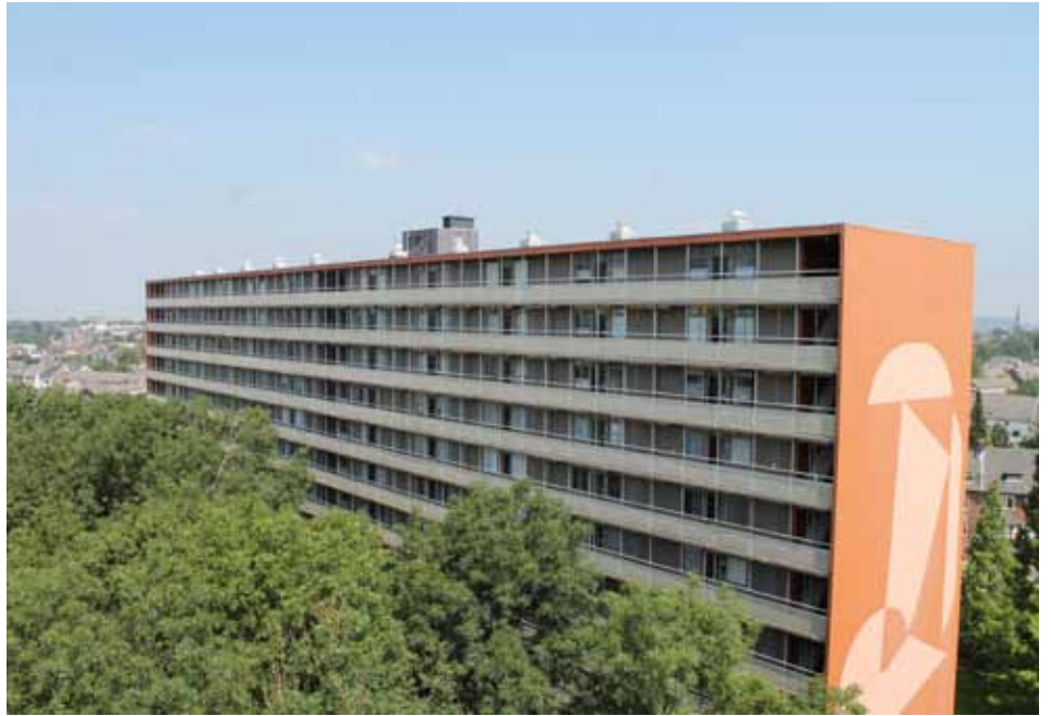
Eines der vakanten Wohngebäude in Kerkrade.
