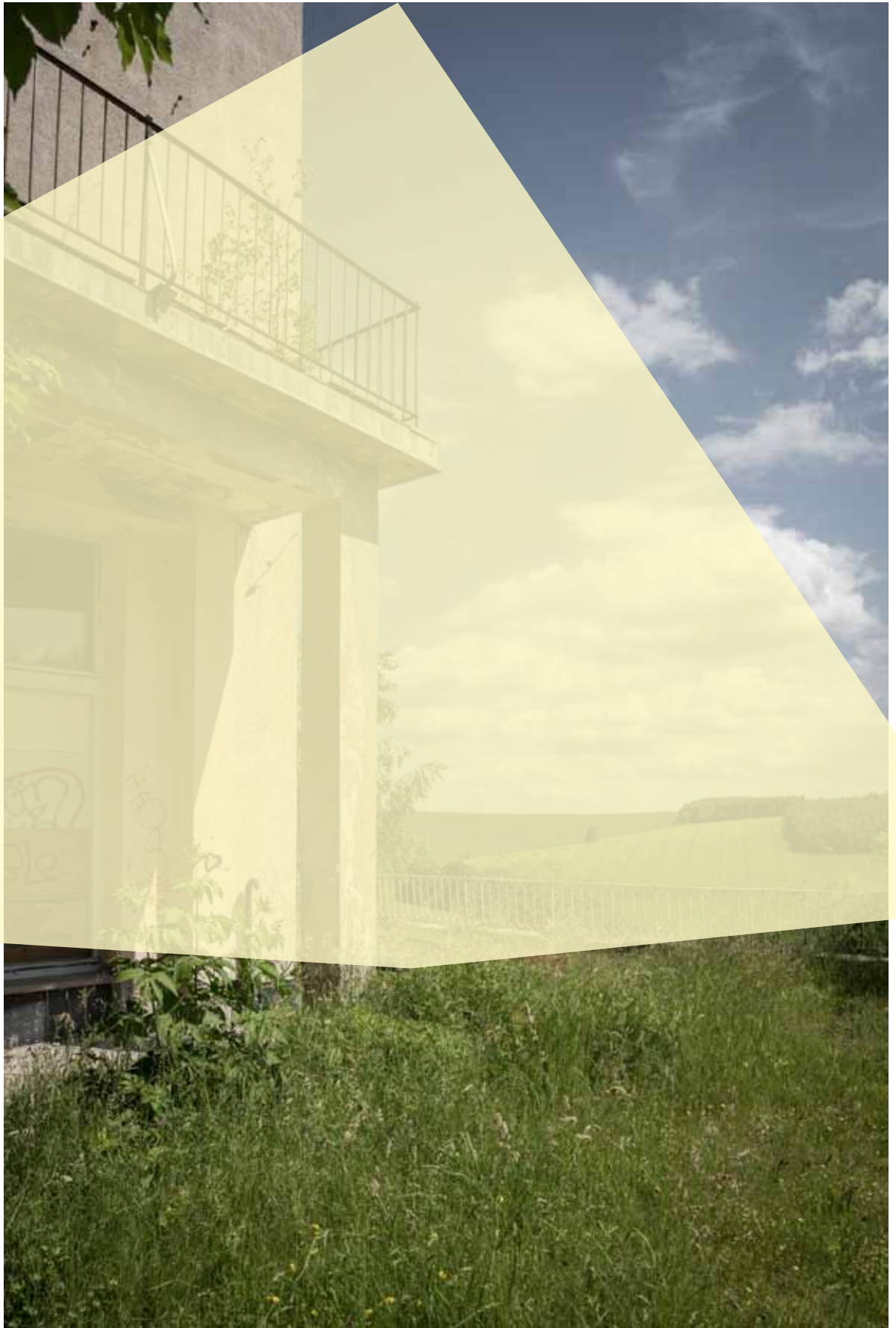
LeerGut in Thüringen: Ehemalige Kultur Klinik in Löhma, 2016
